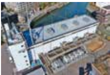
小名木川排水機場
