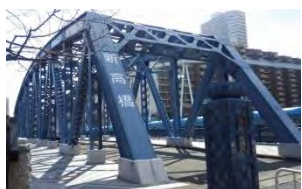
西深川橋とそっくりな新高橋
