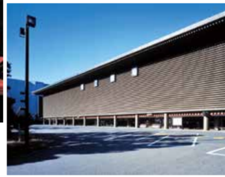
工事前の国立劇場
