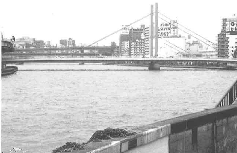
隅田川テラス(常盤1-1)付近から新大橋をのぞむ
