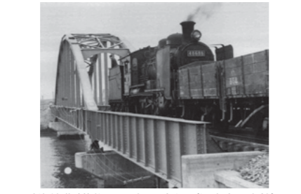
南海線豊洲橋梁 昭和40年頃 (江東古写真館)
