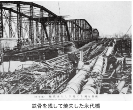
鉄骨を残して焼失した永代橋(国立国会図書館デジタルコレクションより)
