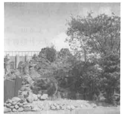
図2 「最晩年」の富士塚。昭和30年(1955)頃。江東区教育委員会蔵。富岡八幡宮社殿裏手。裏の建物は数矢小学校。
