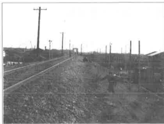
貨物線（昭和30年） 大島2丁目から北砂方向を見る。
