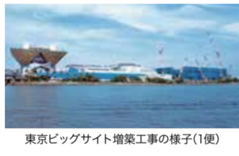
東京ビッグサイト増築工事の様子(1便)
